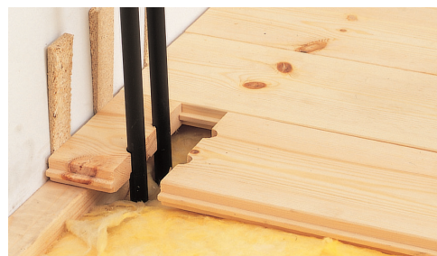
4. Gør hullet 10 mm større end rørets diameter
