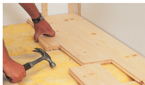
2. Anvend en slagklods som beskyttelse når du slår brædderne sammen
