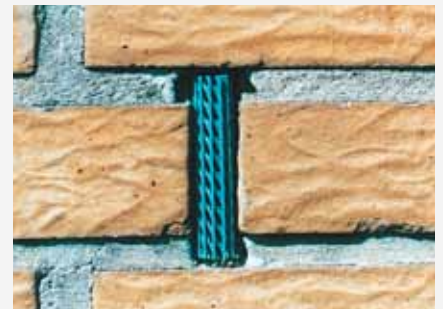
Studsugerør monteret i mur
