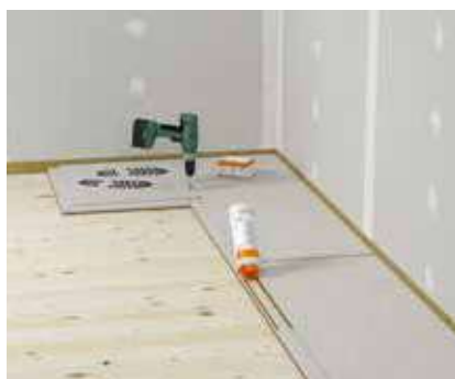
❹ Påføring af fermacell™ Gulvelementlim i falsen.
