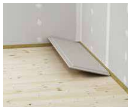
❸ Lægning af fermacell® Gulvelementer.
