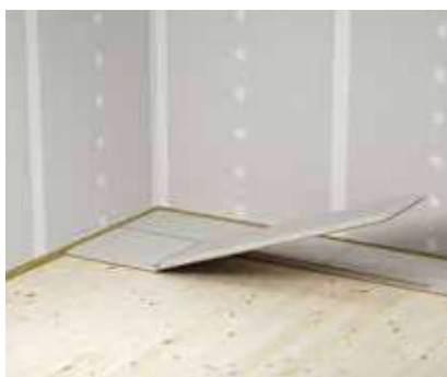
❺ Udlægning af elementer med liming af falssamlingen.
