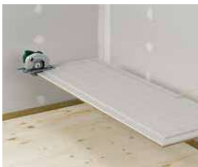
❷ Bortsavning af overskydende fals til lægning af første række.
