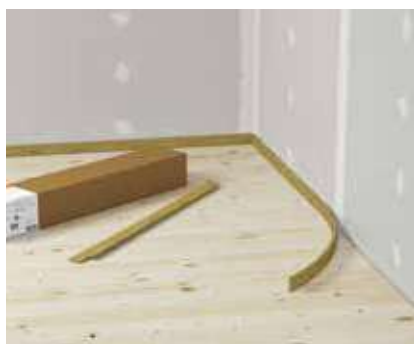
❶ Kantisolering monteres så trinlyden ikke forplanter sig igennem væggen.
