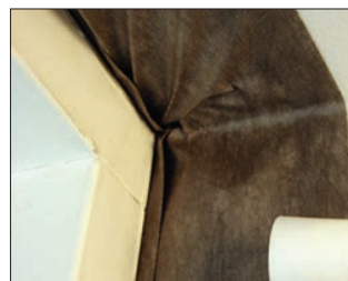
Ved betonvægge fastgøres lysningsfoliens butylklæber til betonfalsen. Samlingen trykkes med en trykrulle. Det skal sikres, at butylen klæber til underlaget.
