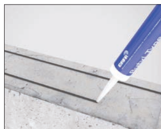
Der udlægges 2 striber butylfuge inden folien udrulles
