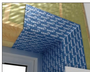
DAFA udvendigt hjørne, monteret i vindueslysning
