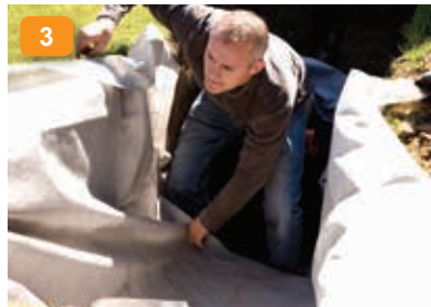
3: Fiberdugen lægges ud i bunden af udgravningen på plant underlag og perforeres i bunden. Placer BIO-BLOK® elementerne med lodret stående rør. Undgå så vidt muligt jord m.m. på dugen.
