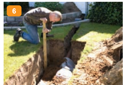
6: Sand fyldes omkring BIO-BLOK® regnvandsfaskinen og stampes godt ned langs siderne for at undgå senere sætninger i terrænet. Hvis pladsen er trang, brug evt. en lægte, et bræt eller tilsvarende.
