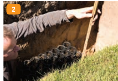
2: Udmål dybden af hullet ved at placere BIO-BLOK® elementerne med lodret stående rør i ca. 50-80 cm dybde, målt fra overkant element til terræn.
