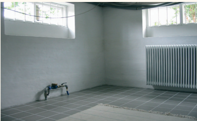
Færdig tør kælder
