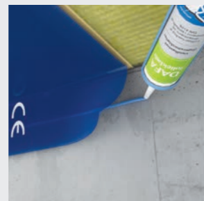
DAFA folieklæb bruges til at etablere en tæt limning mellem dampspærrefolien og underlag som f.eks. puds, beton eller ubehandlet træ.
