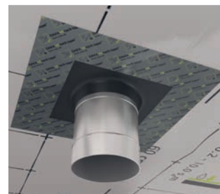
DAFA Hi-tack® rørkrave anvendes til DAFA ExFoil og DAFA HiFoil dampspærreer.
