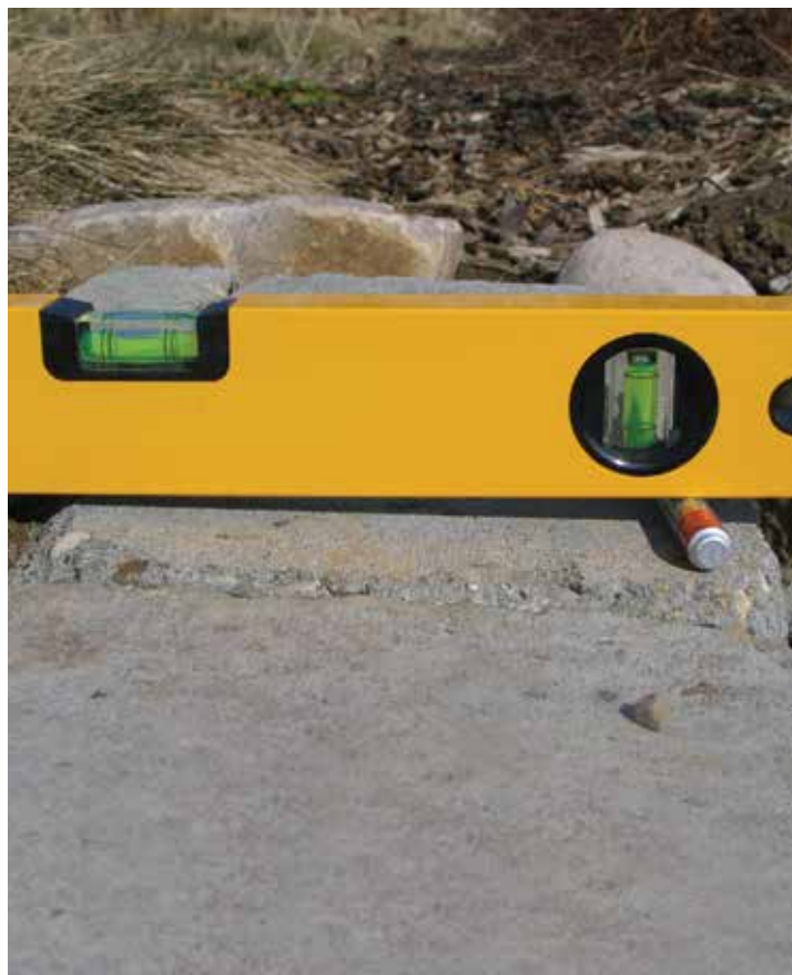
Find en passende genstand ca. 1 cm tyk til at placere under vaterpasset. Så er det nemt at lave det rette fald.
