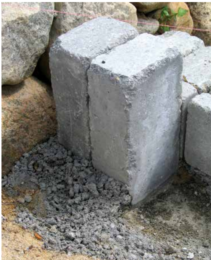
Betonblokkene skal bankes godt ned i den jordfugtige beton. Bagefter laves trekantstøbningen bagved.
