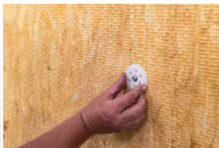
Termodyvlen isættes plan med isoleringensoverfladen.
