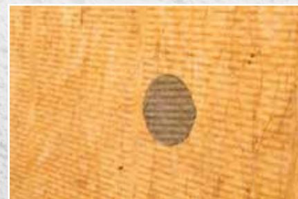
Isoleringsoverfladen er nu klar til grundpuds.
