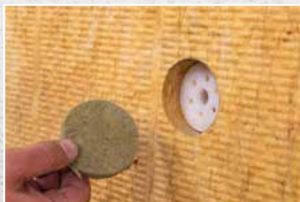
Passende isoleringsrondel monteres.
