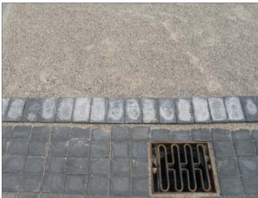
Kraftige kalkudfældninger på sorte sten. Er sådanne udfældninger tilstede ved lægningen skal leverandøren kontaktes for at aftale det videre forløb.
