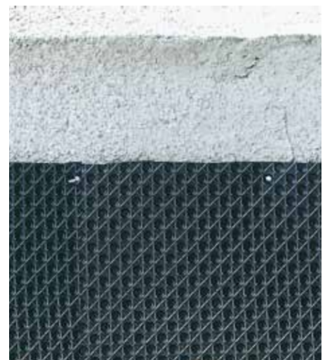
Icopal Universal fastgøres til ydermuren med specielle "propsøm", som er tilpasset knasterne. De sikrer, at pladen ikke trækkes ned af jordsætninger.
