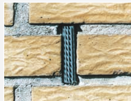
Studsugerør monteret i mur
