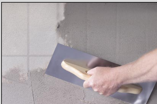
3. MULTIPUDS trækkes på i et jævnt lag med et stålbræt
