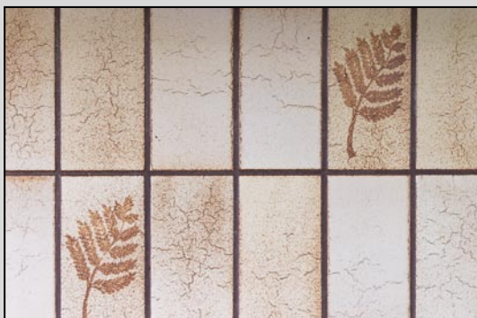
1. Fliserne rengøres grundigt for snavs og fedt med Skalflex Grundrens
