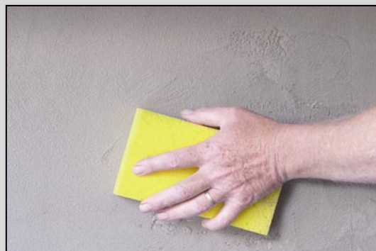
4. Efter nogle minutter filtses overfladen ensartet og jævn med en let fugtet filtsesvamp
