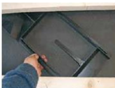
Det øverste element monteres imellem lægter og undertag.
