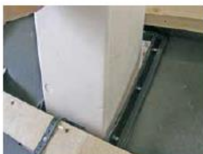
Isorør puttes igennem rørgennemføringen. For at lukke luftstrømme omkring isorøret kan der skummes med skum eller fyldes ud med traditionel isolering.
