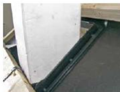
Undertagskraven færdigmonteret set ude fra.
