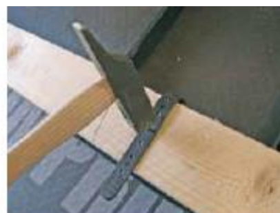
Flap fastgøres med de medfølgende fladhovedede søm.
