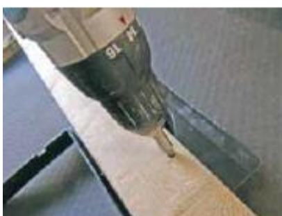
Der skrues 2 stk. max. 45 mm. lange skruer igennem lægten og ned i overkant af undertagskraven. Ribberne på undersiden af kraven sikrer at der ikke kan komme kontakt imellem undertag og skruer.
