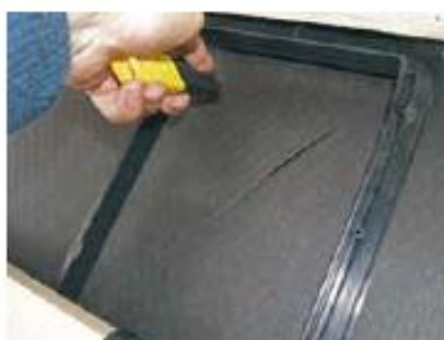
Der skæres et snit fra hjørne til hjørne.
