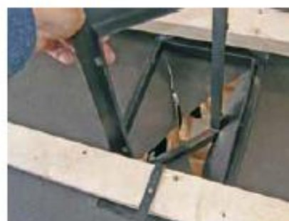
Det nederste element puttes igennem hullet, klikkes fast og skrues i skruenhullerne med de medfølgende 35 mm. skruer.
