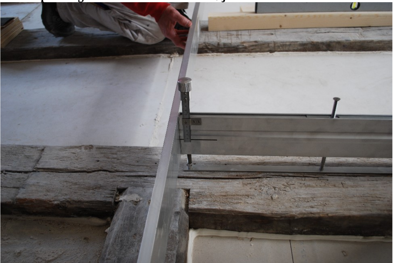
Indstilles nemt ved hjælp af den indbyggede skala
