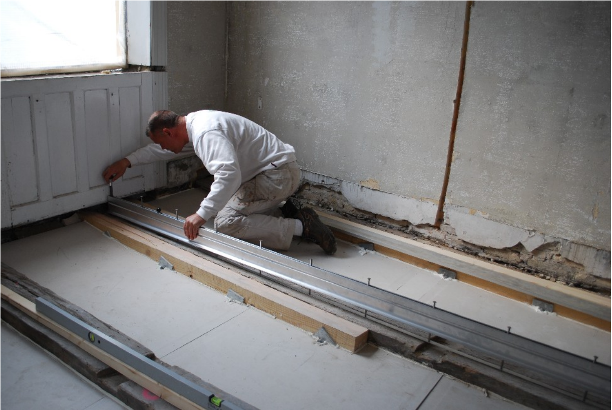
Finnis opretningsskinne stilles til korrekt højde..
